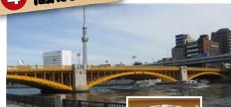
架橋1927(昭和2)年、全長173.2m、全幅22.3m 蔵前橋通り、台東区蔵前1丁目～墨田区横網2丁目間
